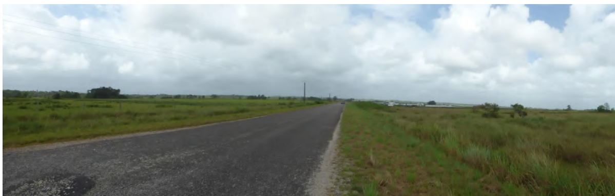
Fig. 47. Vue du projet depuis la Route de St Elie en direction du Sud
