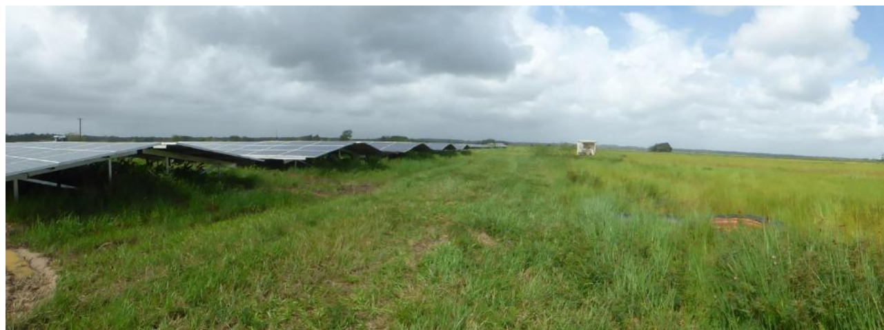
Fig. 1. Vue de l'installation existante (à gauche) et de l'emprise de la future extension (à droite)
