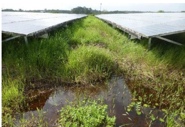
Point bas en eau entre les rangées de modules (saison des pluies)
