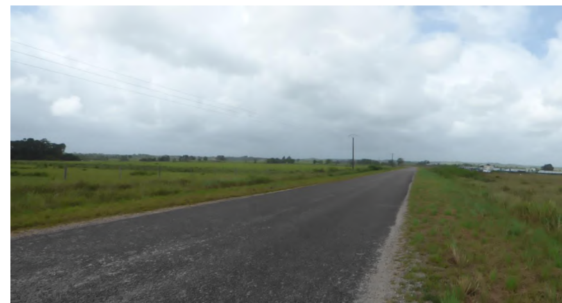
Fig. 54. Route de Saint Elie en bordure du projet
