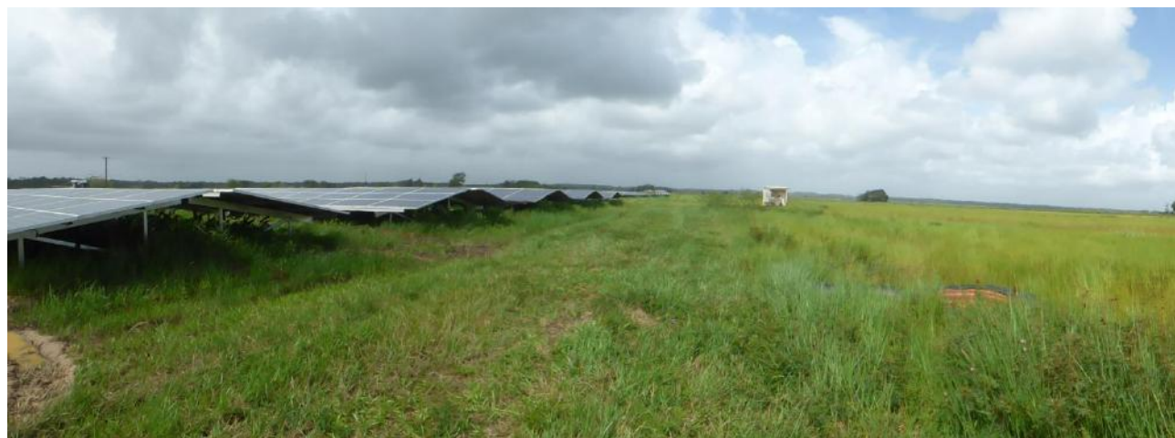
Fig. 11. Vue de l'installation existante (à gauche) et de l'emprise de la future extension (à droite)
