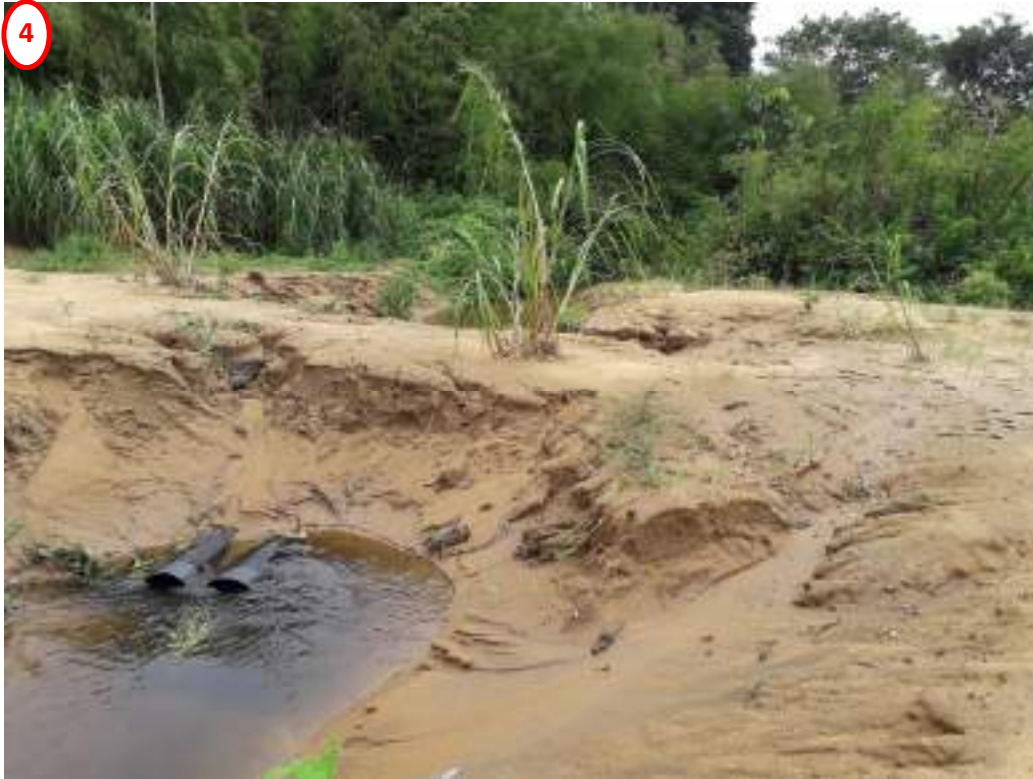
Figure 3 : Axe d'écoulement situé en amont du talus de stockage (Suez consulting Février 2022)
