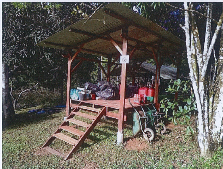
Figure 10: Carbet matière dangereuses sur le site de Pararé (bacs de rétentions présents).
