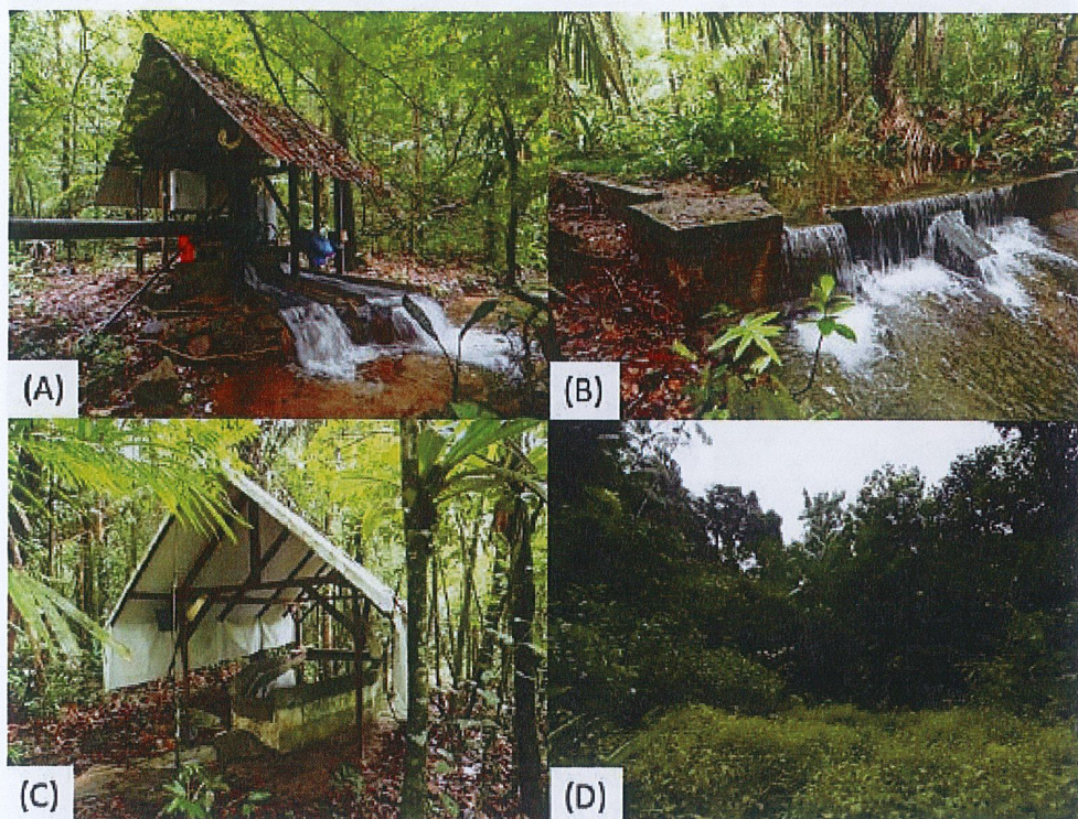
Figure 4: Infrastructures liées à la turbine sur la crique Cascade (A) carbet turbine, (B) barrage, (C) carbet bassin, (D) ouverture pour évacuation de la turbine.
