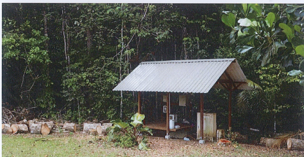
Figure 5: Carbet transformateur rénové sur la DZ Inselberg en Mars 2019
